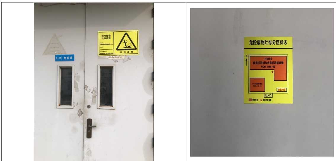
危废暂存间 1 内外部图
