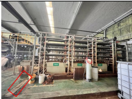
污水处理站地沟
