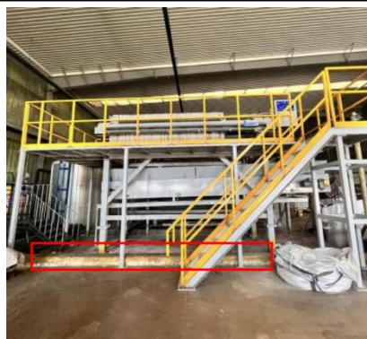
污水处理站围堰
