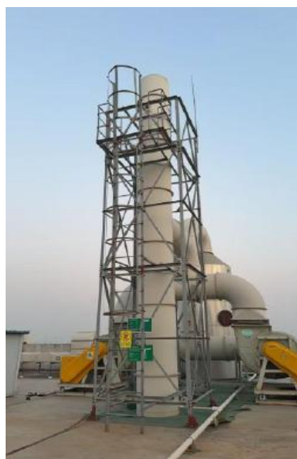
排气筒 P7 采样平台
