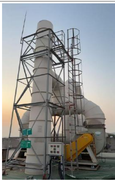
排气筒 P8 采样平台
