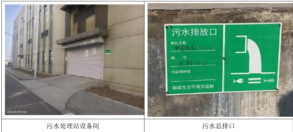
图 4.1-2 全厂综合污水站
