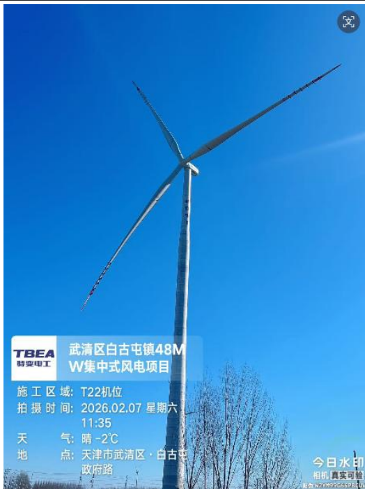
T5 (T22) 风机建设情况
