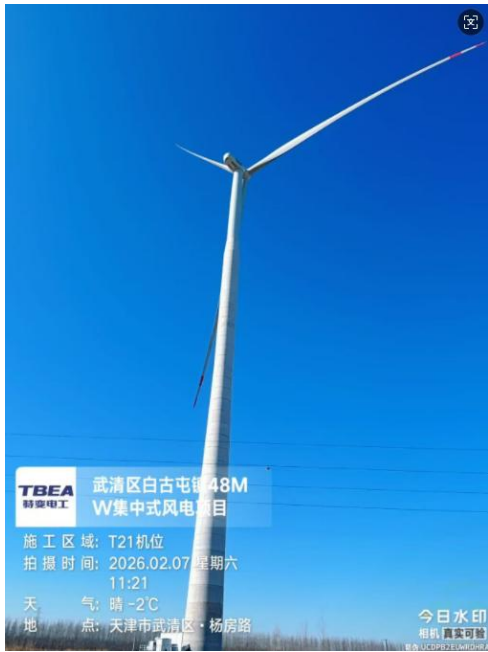
T3 (T21) 风机建设情况
