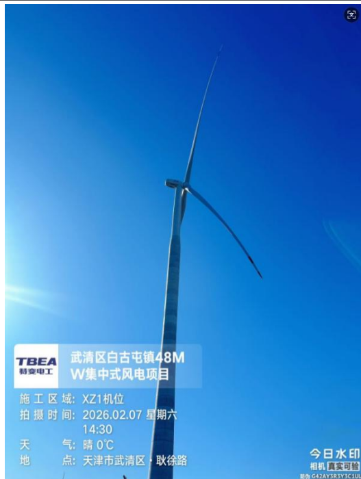
T8 (XZ1) 风机建设情况
