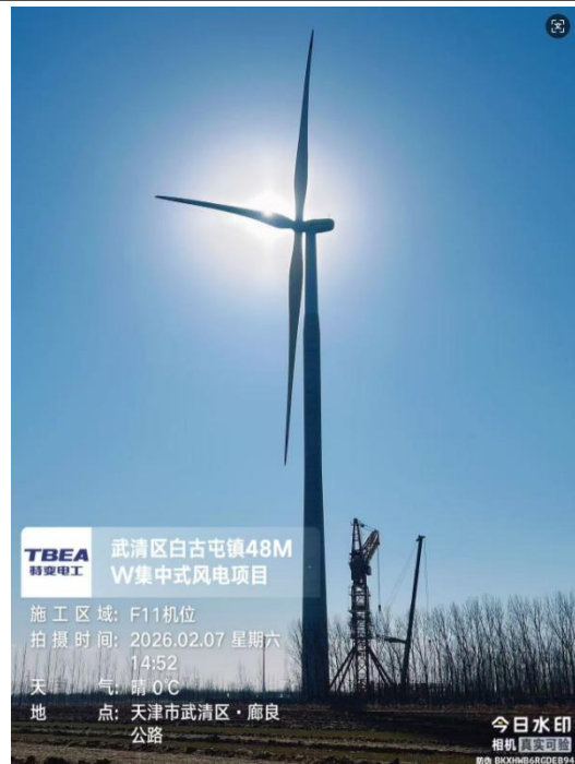
T10 (F11) 风机建设情况
