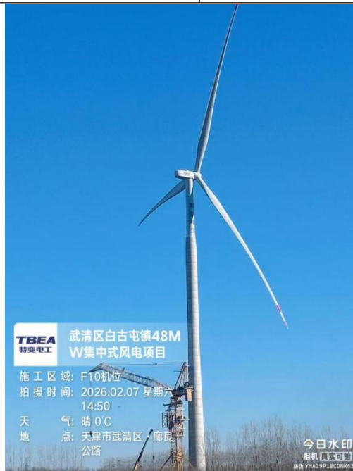
T11 (F10) 风机建设情况
