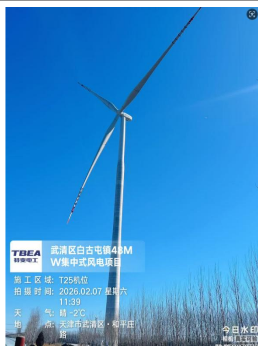
T6 (T25) 风机建设情况
