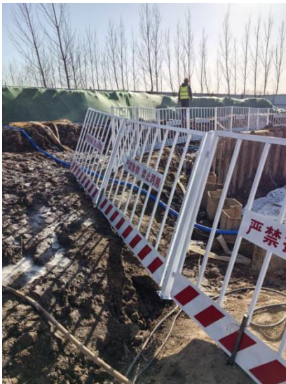
施工期风场区围挡
