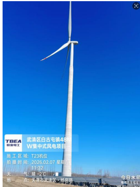
T4 (T23) 风机建设情况
