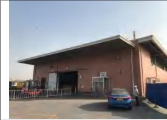
一般固体废物库
