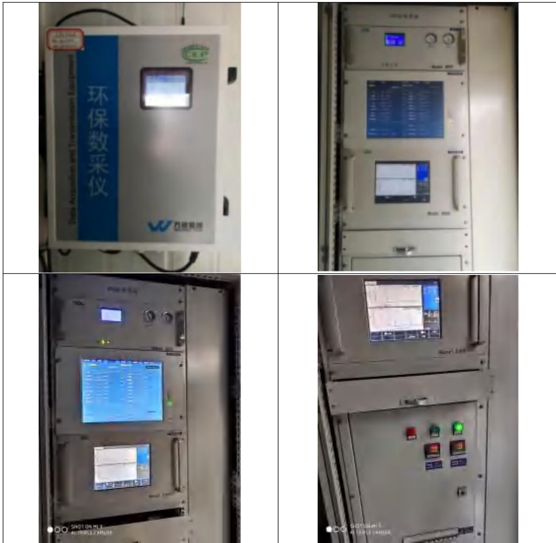
图 3.5-1 废气在线监测装置照片
