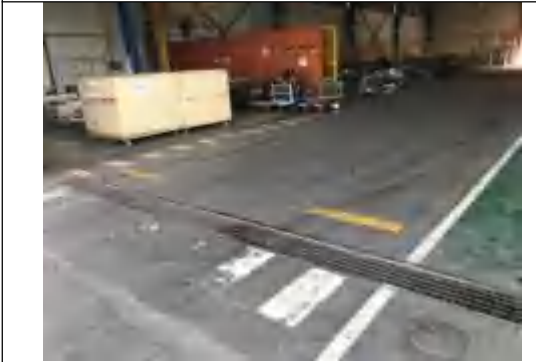
一般固体废物库内部
