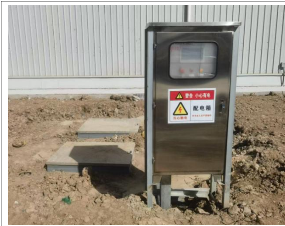
事故水提升泵
