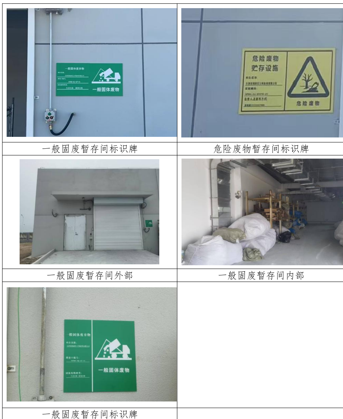
图 4.1-4 固体废物暂存设施规范化照片
