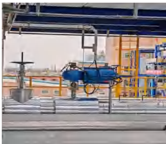
温度、压力传感器及紧急切断阀
