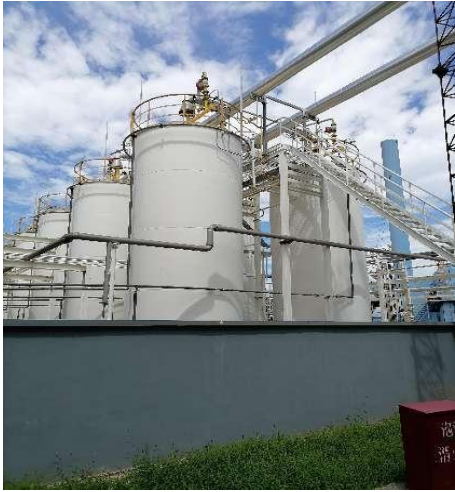
储罐区防火堤
