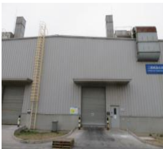
危废暂存间外部
