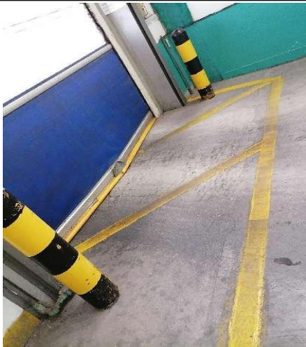
车间门口缓坡
