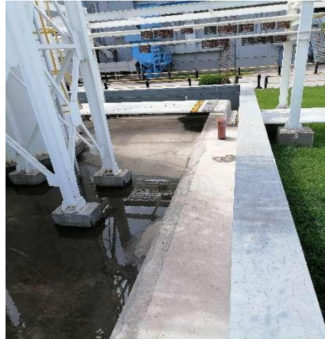
储罐区防火堤（内部）
