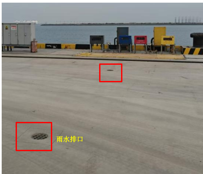
图 8.2-1 码头雨水排口
