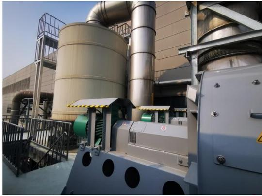
排气筒 P2 的冷凝+喷淋塔
