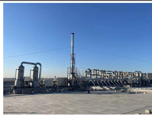
中试车间发酵废气治理设施及排放口 DA007(P8-1)
