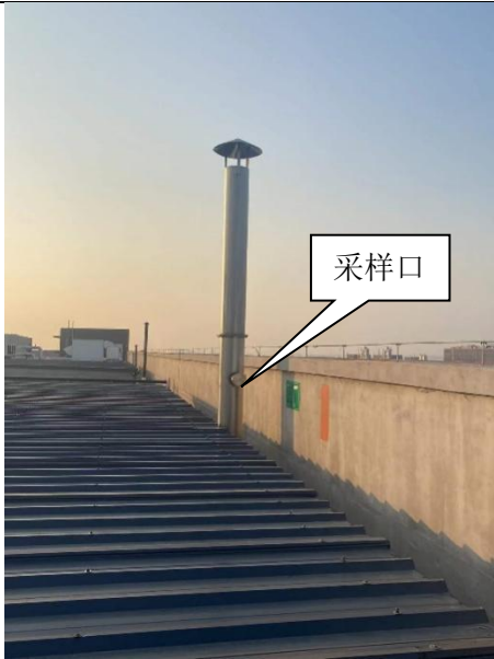
中试车间喷雾干燥废气排口规范化 DA011(P28)
