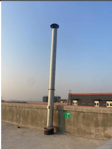
发酵车间 1 喷雾干燥废气排口规范化 DA012(P29)
