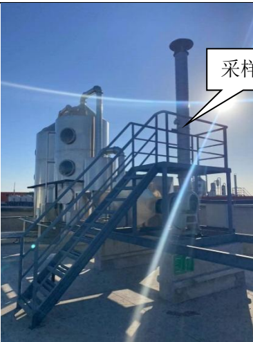
HA 精制车间 1 精制废气治理设施及排放口 DA003(P16)
