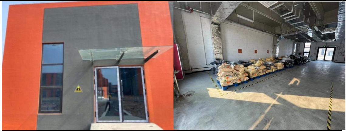
危险废物暂存间二
