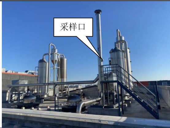
发酵车间 1 发酵废气治理设施及排放口 DA005(P6-1)
