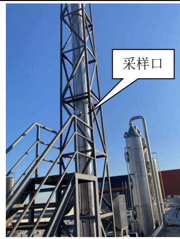
发酵二车间发酵废气治理设施及排放口 DA006(P6-2)
