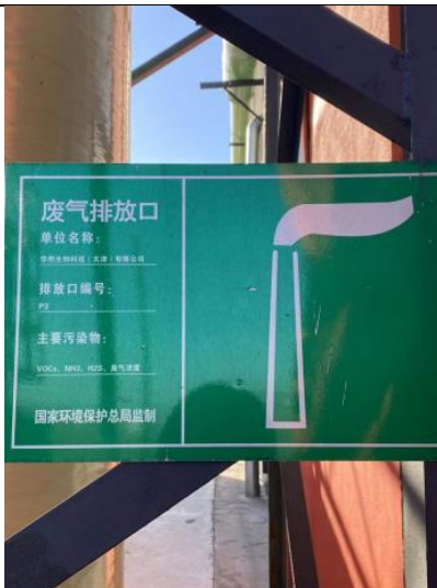
污水站废气排放口 DA001(P3)标识牌
