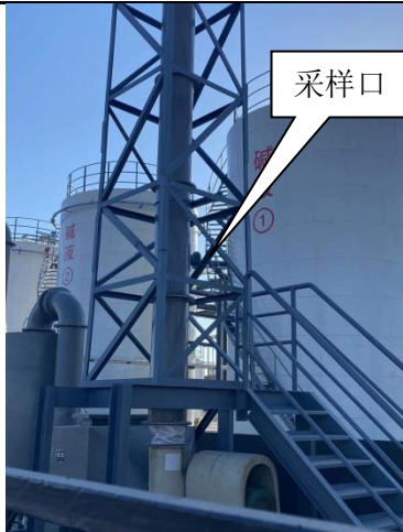
罐区废气排放口 DA002(P5)规范化
