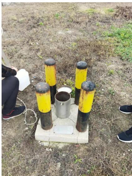
地下水监测井
