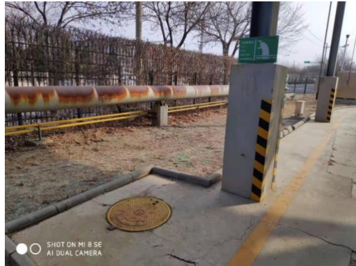
厂区东北侧污水排口
