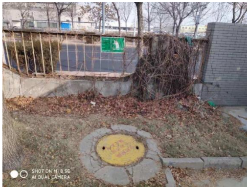
厂区北侧污水排口
