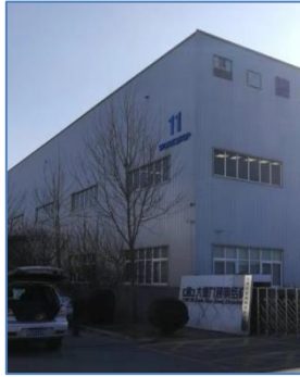
图 11 厂址南侧大德九通钢结构公司厂房照片
