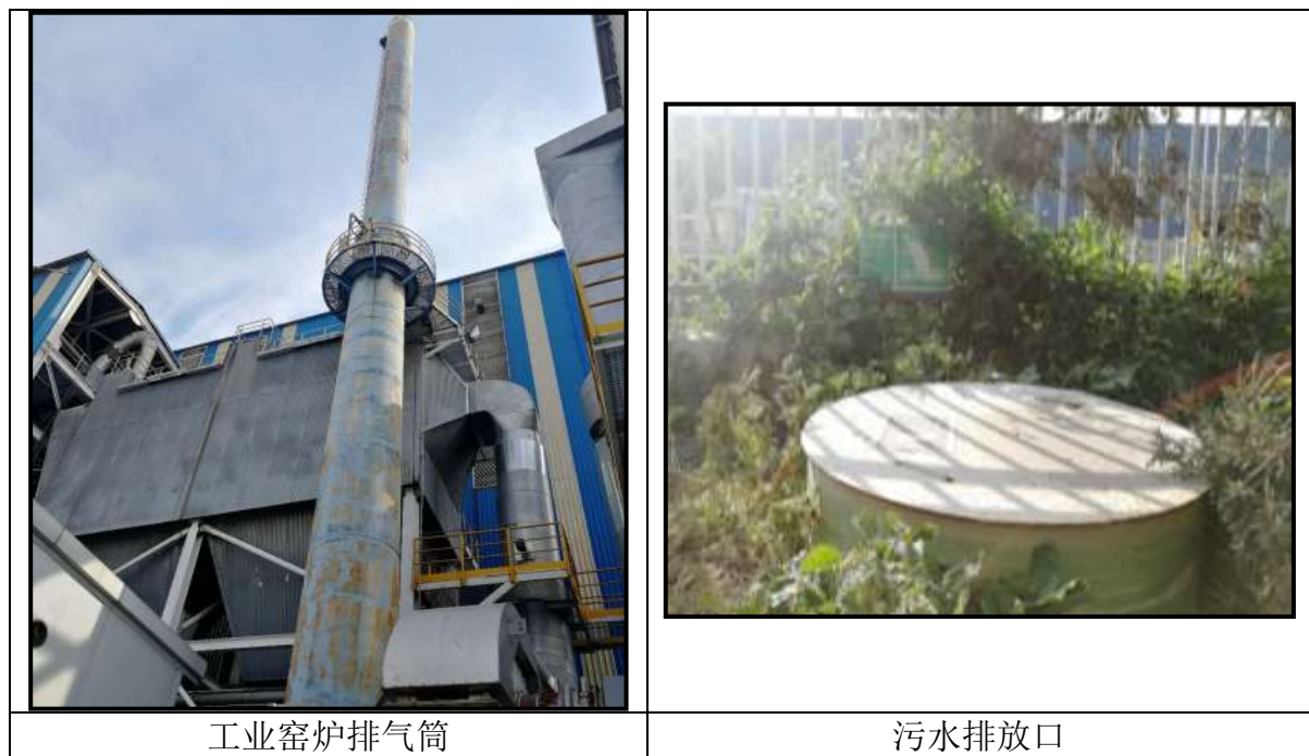
图 1-7 现有工程排污口现状图片
