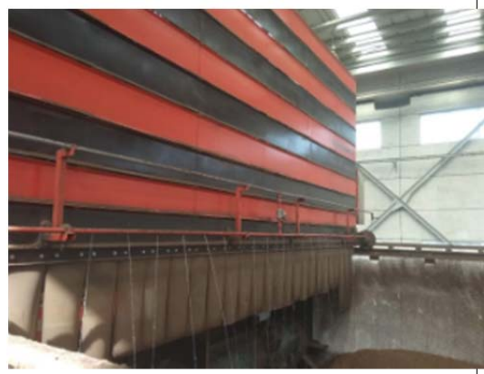
发酵车间喷淋系统
